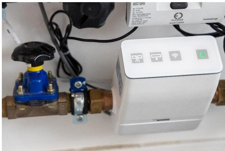
Figure 1 Dispositif de détection de fuite installé sur le démonstrateur sanitaire de Buildwise. Ce système intègre une vanne motorisée et fonctionne à la fois par monitoring de la pression et du débit.
